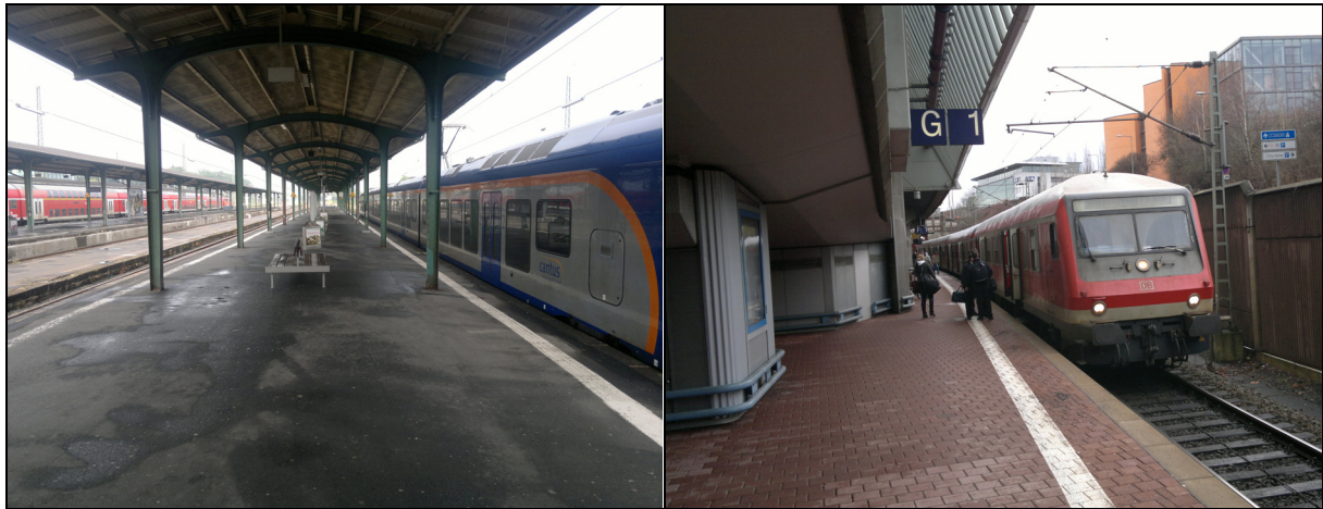
Abb. IV-6: Fehlende taktile Leitsysteme am Kasseler Hbf. (EBO-Bereich; links) und am Fernbahnhof Kassel-Wilhelmshöhe (rechts)
