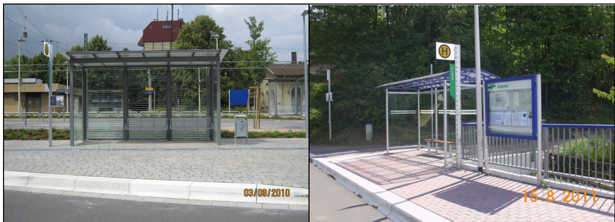
Abb. II-30: Beispiele für modernisierte Bushaltestellen an Bahnstationen: Felsberg-Gensungen (links) und Wildeck-Bosserode (rechts)
