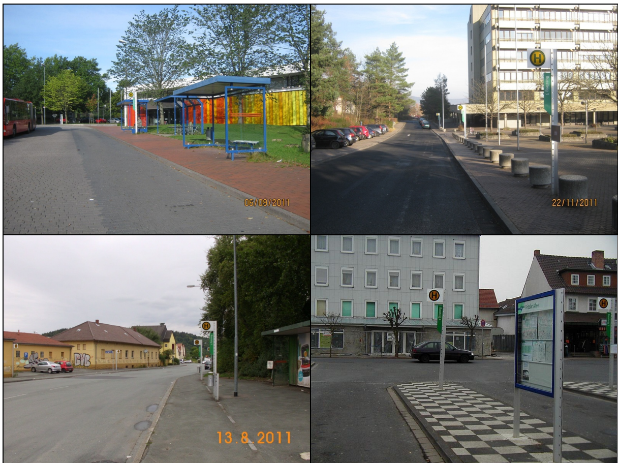
Abb. IV-16: Beispiel für Haltestellen an publikumswirksamen Einrichtung (obere Fotoreihe) und für zentrale Umsteigehaltestellen (untere Fotoreihe) in ausbaufreiem Zustand
