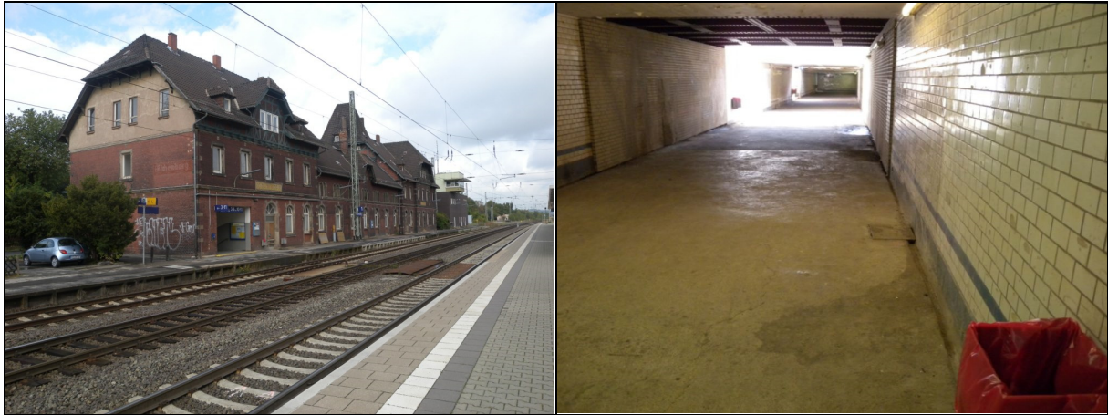
Abb. IV-7: Leer stehendes Empfangsgebäude (links) und unzeitgemäße Bahnsteigunterführung (rechts) in Eichenberg
