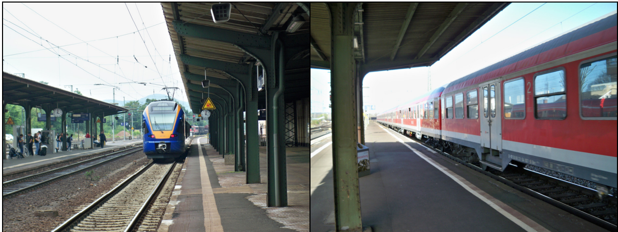
Abb. IV-4: Nicht miteinander korrespondierende Bahnsteig- und Einstiegshöhen in Bebra (links) und in Wabern (rechts)
