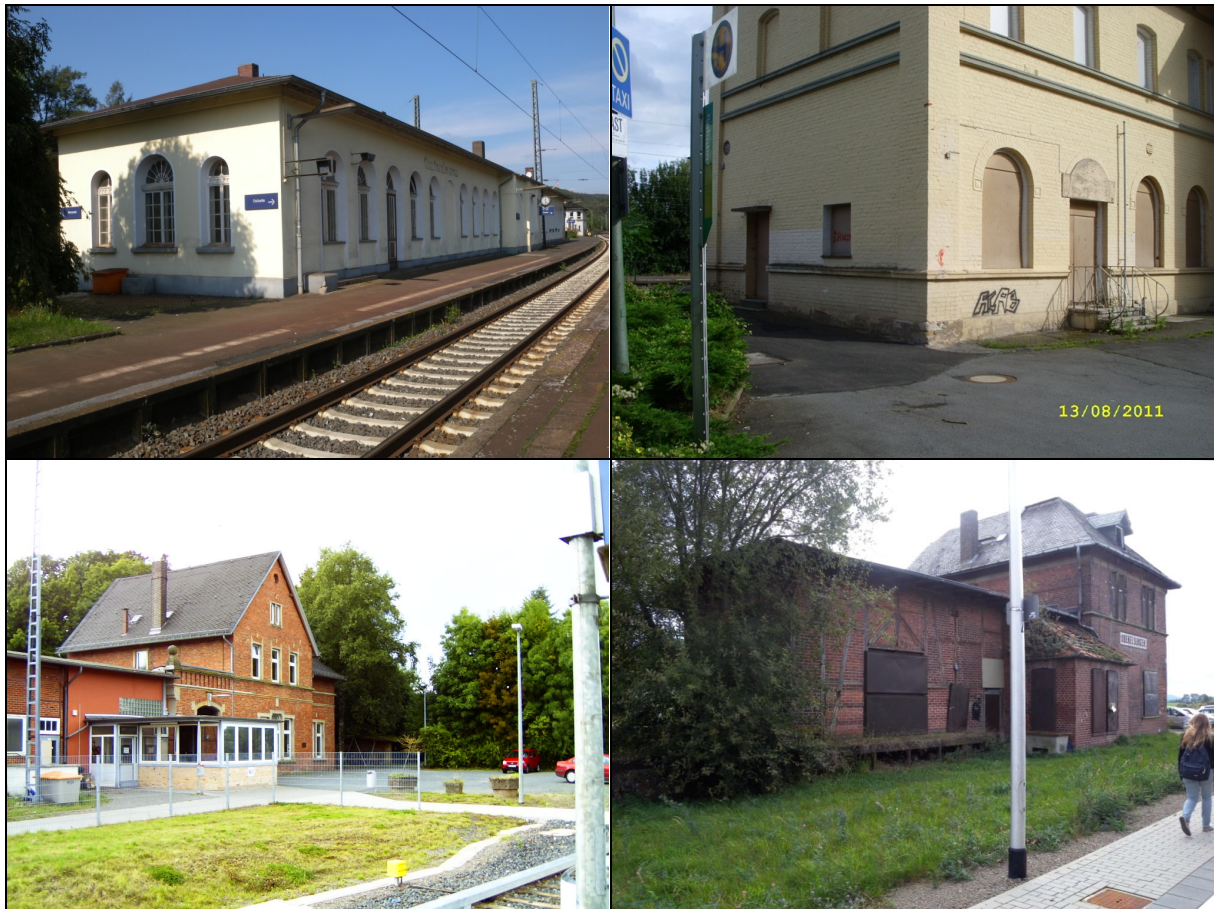
Abb. IV-12: Bauspiele für leer stehende und ungenutzte Empfangsgebäude: Baunatal-Gunthershausen (links oben), Sontra (rechts oben), Wolfhagen (links unten), Zierenberg-Oberelsungen (rechts unten)
