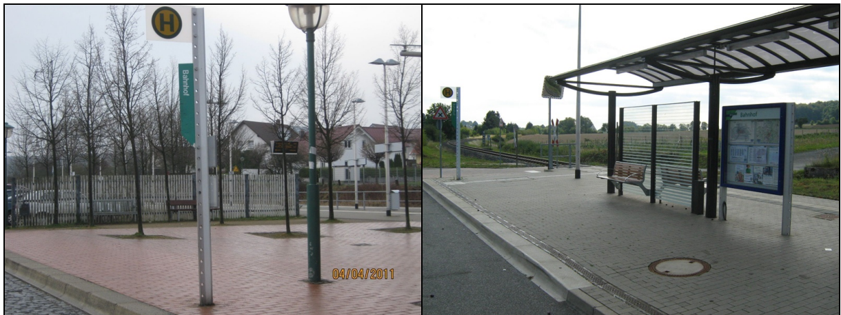
Abb. II-28: Baulich integrierte Umsteigeanlagen im RegioTram-System: Ahnatal-Weimar (links) und Calden-Fürstenwald (rechts)
