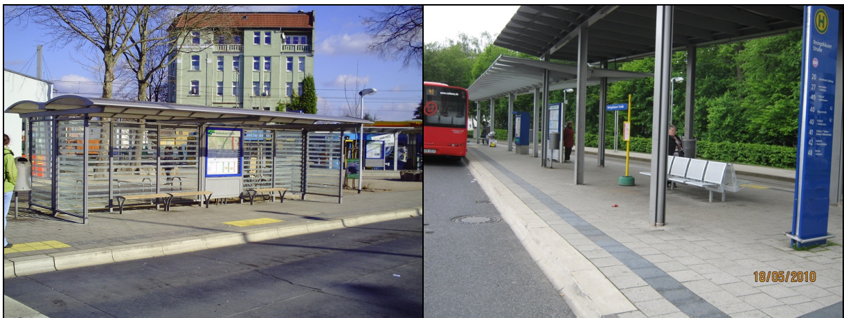
Abb. II-26: Baulich integrierte Umsteigeanlagen zum regionalen Busverkehr im städtischen Tramnetz Kassels: „Holländische Straße“ (links) und „Ihringshäuser Straße“ (rechts)
