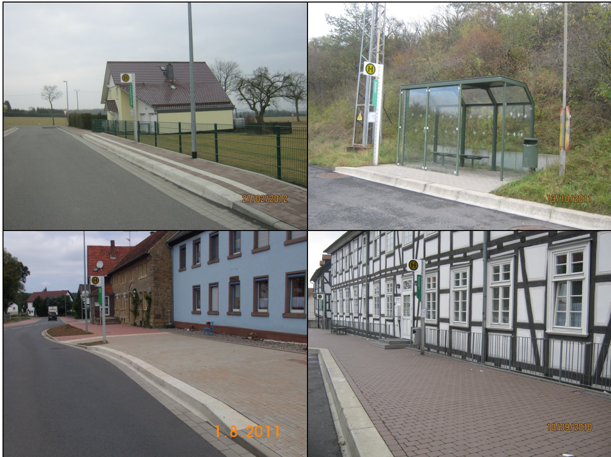
Abb. IV-17: Beispiele für ausgebaute Haltestellen entlang regionaler Buslinien mit eingeschränkter barrierefreier Nutzbarkeit für mobilitätseingeschränkte Fahrgäste
