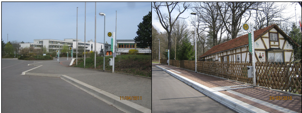
Abb. II-31: Beispiele für modernisierte Haltestellenanlagen an Schulzentren: Korbach „Kreisberufsschule“ (links) und Willingshausen-Steinatal „Melanchthonschule“ (rechts)
